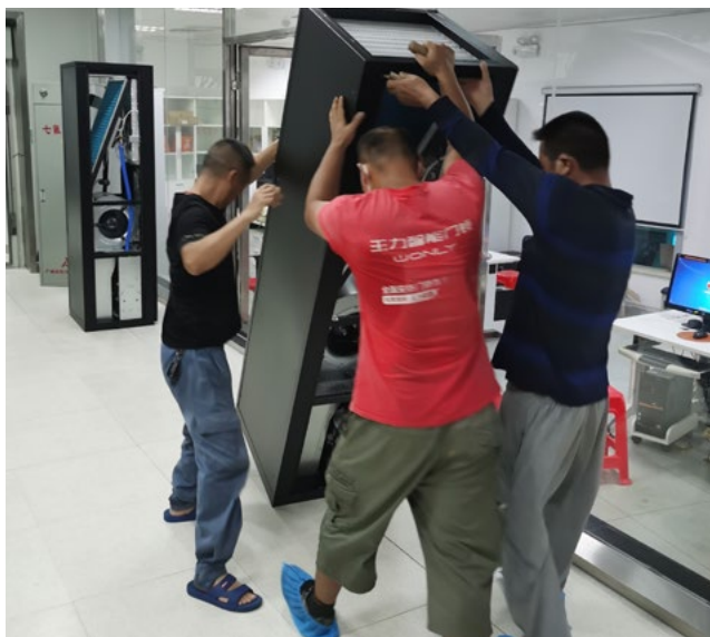
更换安装机房精密空调
